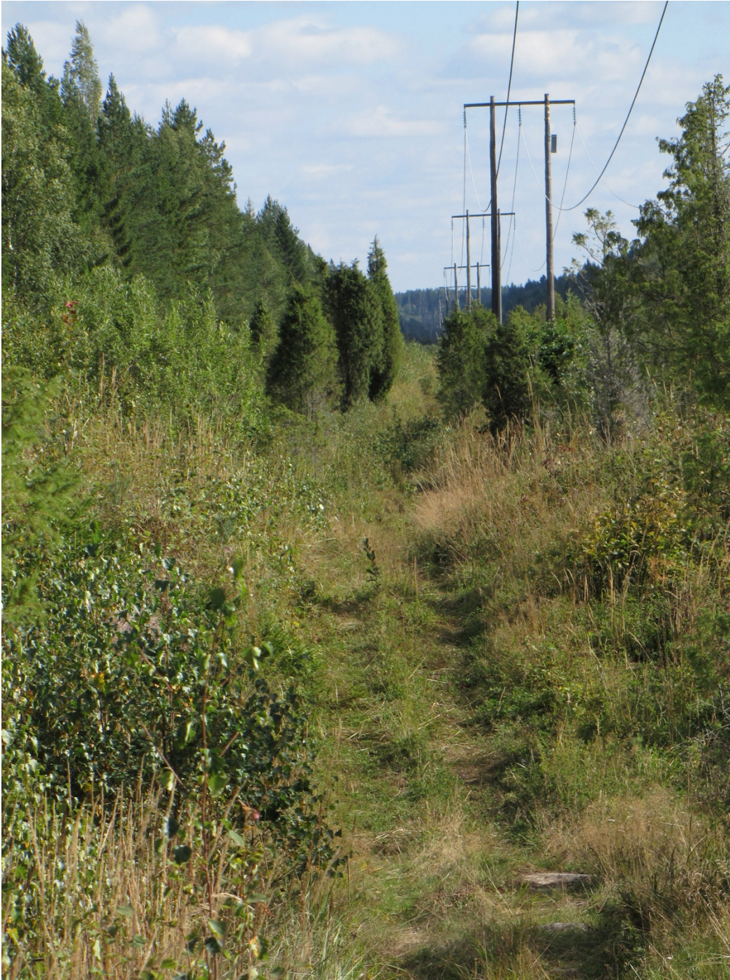
Krafledningsgatan vid Gustavmurarna 2014. Foto Tommy Lennartsson
