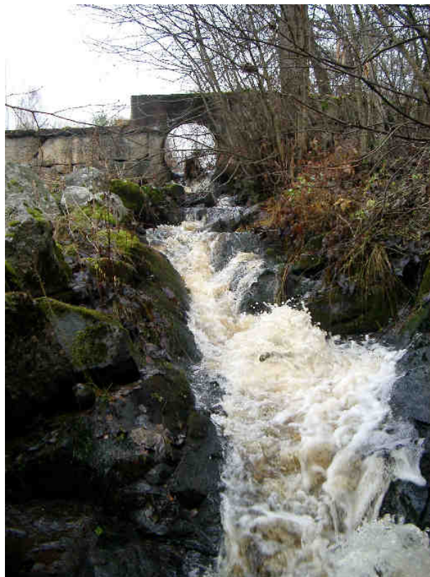
Foto 8. Rännan vid Stenviksdammen. Här kan en slitstrappa byggas. Huvuddelen av vattenflödet går till vänster utanför bild.
