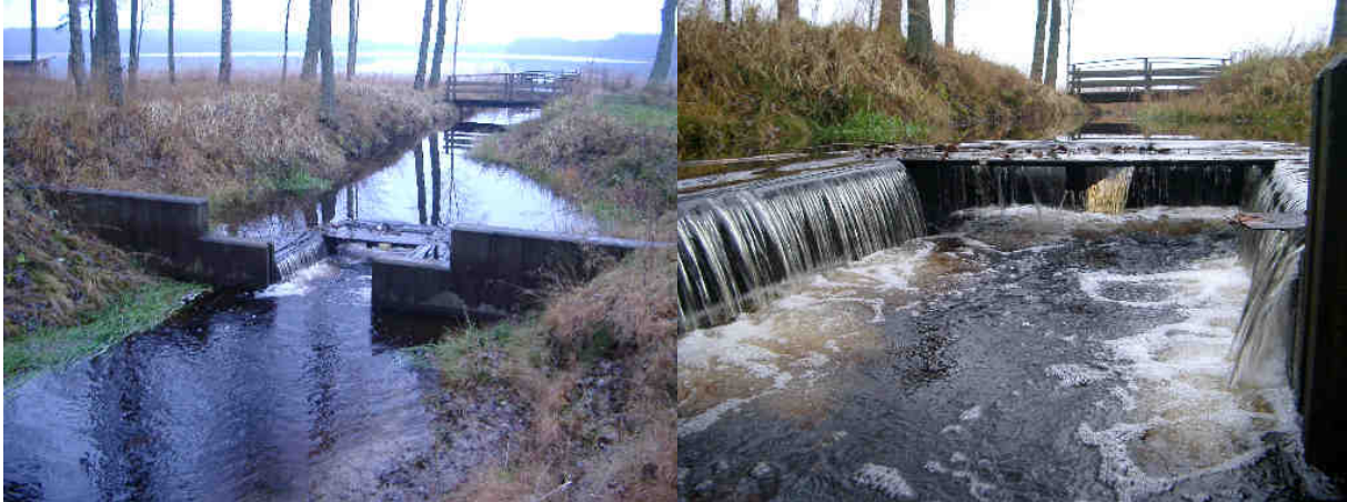
Foto 11 & 12. Damm nedströms Siggeforasjön.
