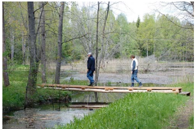
Fig 12: Bron i sjöns södra del har fått byggas om på grund av ökat vattenstånd.
