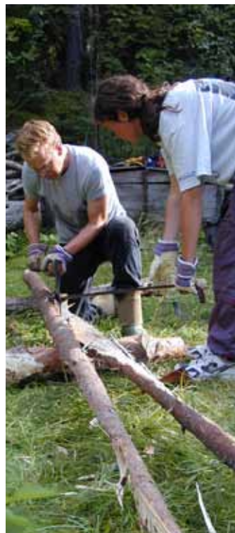
Bygge av trågärdesgård
