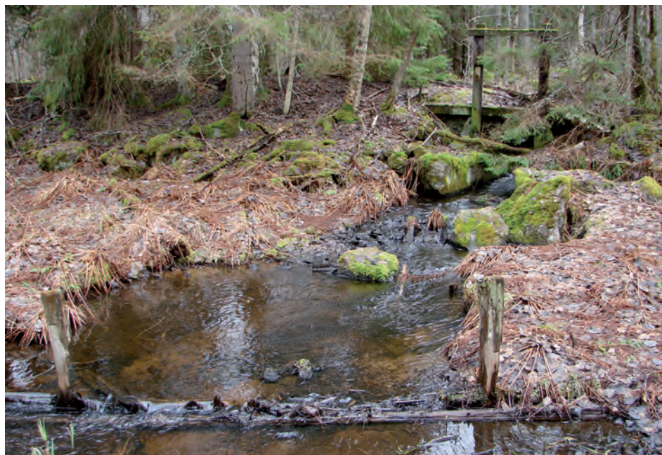
Från den läckande flottningsrännan har en liten bäck bildats, som i sin tur har skapat ett fuktigt mikroklimat som gynnar flera skyddsvärda arter.
