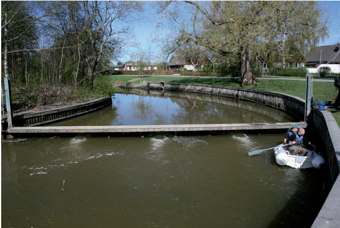
Figur 3. Dämnet vid Drömparken 8 maj 2012 med de tre hålen där vatten kan passera.
