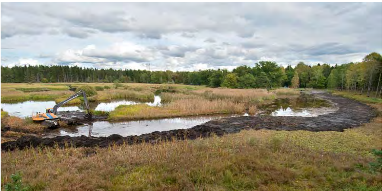
Figur 64. Pågående restaureringsarbete i Dalkarlskärret. Foto från det västra fågeltornet, 22 sept. 2015.
