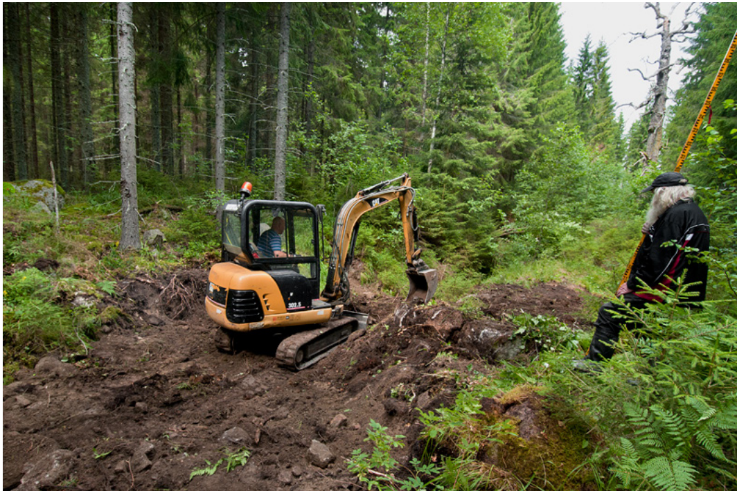
Bild 7. På en cirka 10 m lång sträcka, intill glupen, fylldes diket igen med tidigare uppgrävda schaktmassor. Avvägningsinstrument användes för att avgöra lämplig höjd på dämningen.
