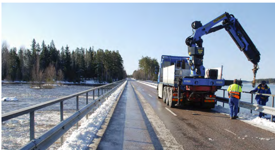
Överskottsvatten ska enligt en överenskommelse släppas genom forsområdet, men bara en gång per år. Lucköppningen är omständig och görs manuellt vilket leder till att mycket vatten som skulle komma forsområdet tillgodo inte kommer till användning. Bredforsen, april 2010.
