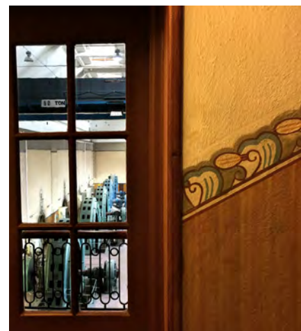
Untra kraftverk byggdes mellan år 1916–18. Interiören präglas av dåtidens framtidsoptimism knuten till den framväxande industrin och elektrisiteten.
