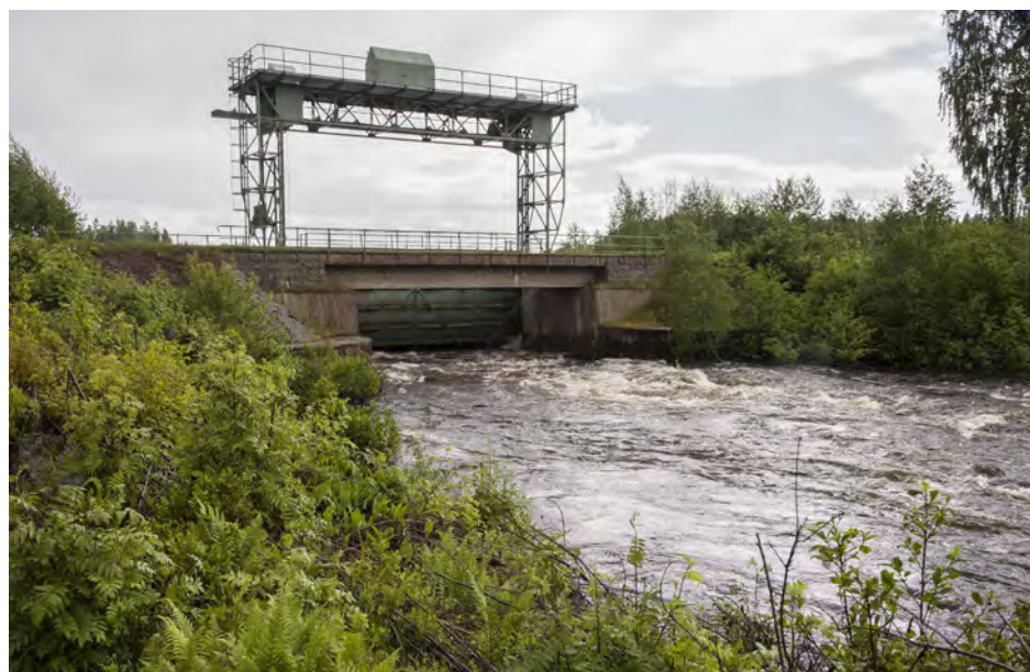
Luckan vid Djupeströmmen vid en provtappning på 80m 3 /s. juni 2015.
