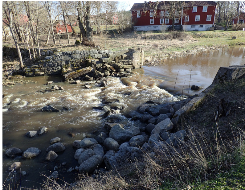
Bild 6. Det utrivna dämnet vid Vansjöbro vid lågvatten våren 2021. Vid lågt värsvatten kan aspen möjligen ha svårt att passera uppströms varför en enklare grävning borde genomföras så att problemen avhjälpas.
