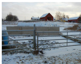
Fastgödsel från utfodringsplatser under kan skrapas bort och lagras på en gödselplatta.
