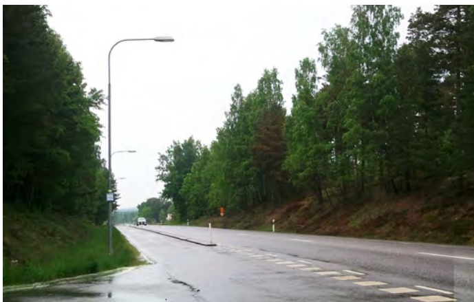
Exempel på gång- och cykelväg som avskiljs från körbana med gcm-stöd samt pollare.
