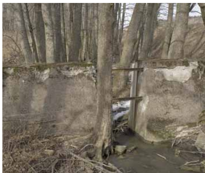
Den gamla fördämningen. Foto: 28 mars 2008, 1596870 x 6604190 mot NV.
