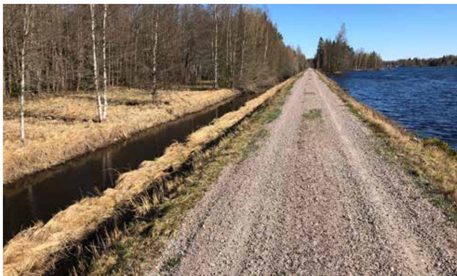
Dammvallen vid Råmsön gör att svåmskogen torrlagts och växer igen, april 2020.
